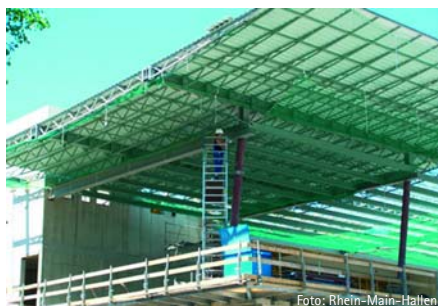
Umbauarbeiten in vollem Gange
